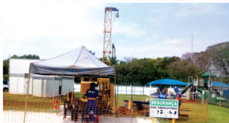
Sondagem Rotativa para embaixada americana em Brasília-DF.
