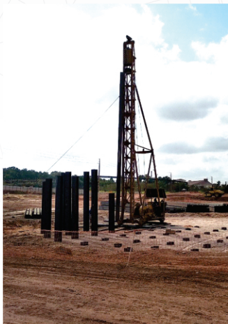
Cravação de 555 toneladas de perfis metálicos em São Luis-MA.
