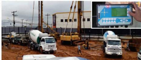
Execução de estacas hélice contínua no Shopping Centro Oeste Outlet em Goiânia-GO.
