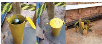
Instalação de referência de nível profundo (Benchmark) em Goiânia-GO.
