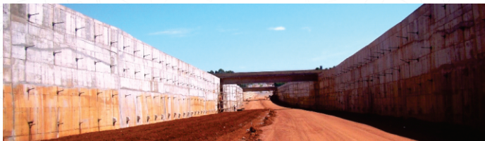
Execução de cortina com 14.000 metros lineares de tirantes, com estacas hélice justapostas e parede de concreto, no viaduto da BR-153 -GO, em Hidrolândia-GO.
