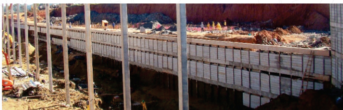
Cortina atirantada com 18,50 metros de altura em Senador Canedo-GO.
