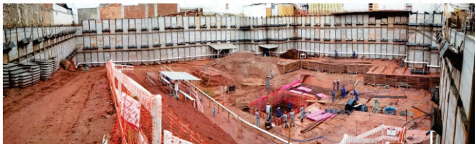
Contenção com perfil metálico de 3 subsolos em Goiânia-GO.
