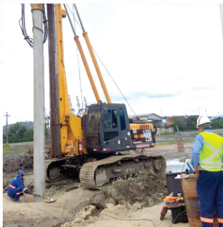
Ensaio de Carregamento dinâmico (PDA) em Estacas Pré-Moldadas de Concreto.
