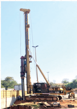
Cravação de estacas metálicas na BR-153 em Aparecida de Goiânia-GO.
