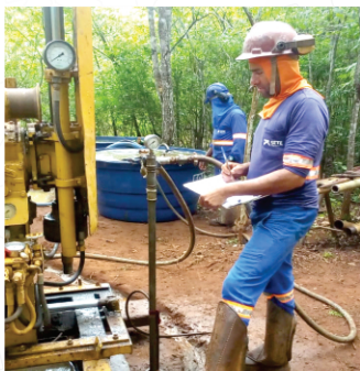
Ensaio de Perda D'água em Rio Verde-GO.
