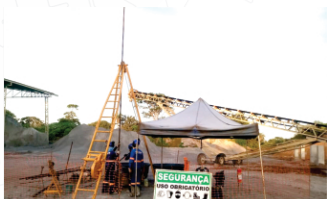
Sondagem SPT em Vila Propício-GO.
