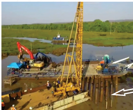
Cravação de tubos metálicos no rio Tocantins. Bases para torre de 180 metros de altura, linha de transmissão 500kV.
