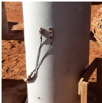
Sensores de PDA instalados em estaca pré-moldada.
